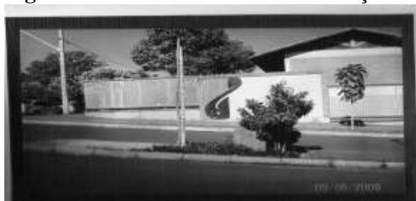
Figura1: Ponto de ônibus sem sinalização
